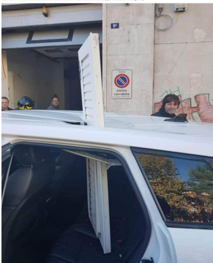
Scurelto di una finestra sfonda il tettuccio di un'auto in sosta (© Alessandro Zagaria)
