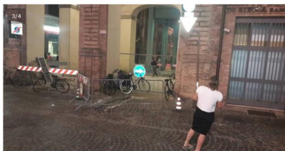
La zona era già transennata per lavori di pavimentazione
