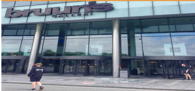
Ingen blev heldigvis ramt, da der faldt et vindue ud fra Bruuns Galleri. Centerchefen beroliger med, at der ikke er risiko for at andre vinduer falder ud. Privatfoto: Michael Bernstorff
